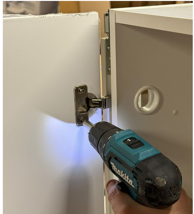
23. Kiinnitä lopuksi ovet saranoihin.
